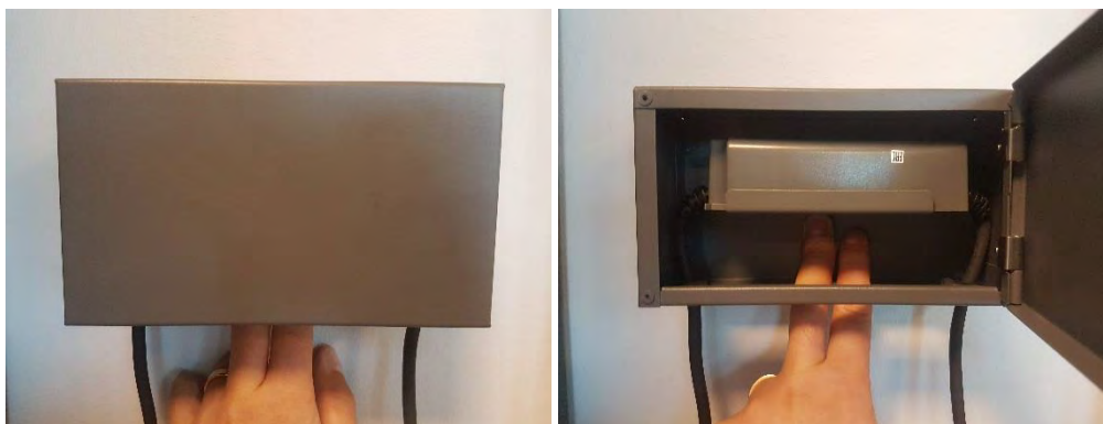
Foto fra installation af en netadapterboks på en væg. Netadapteren placeres i netadapterboksen.
