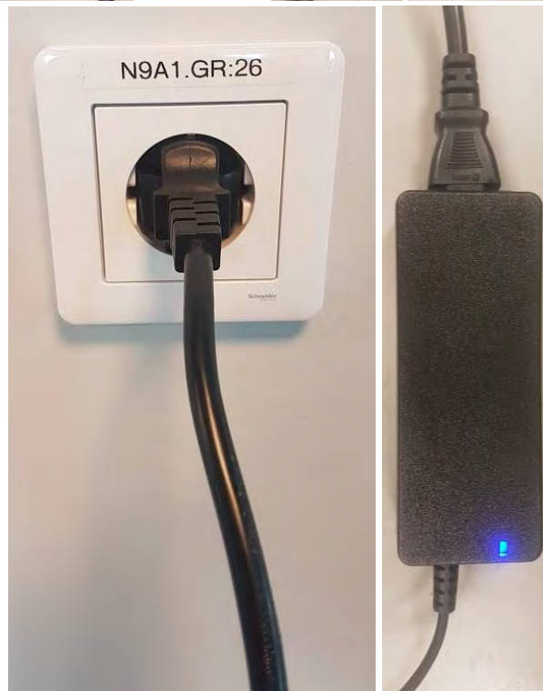
Foto fra installation af et postkasseanlæg, som tilsluttes et jordet udtag med 230 VAC @ 50 Hz via netadapter.
